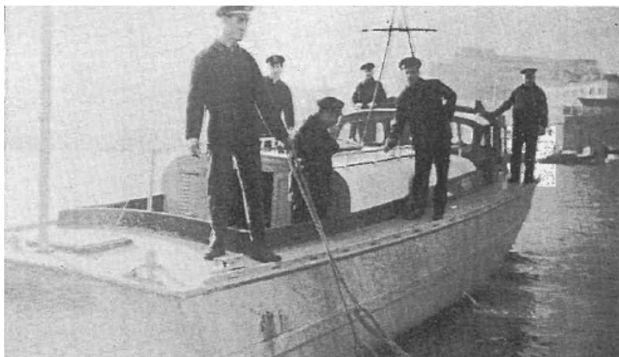
La vedette côtière Matelot Baixas qui fait naufrage le 9 mars 1960 sur les rochers de La Moutte (Golfe de Saint-Tropez) (Photo offerte à l'auteur par le Contrôleur Glories)
